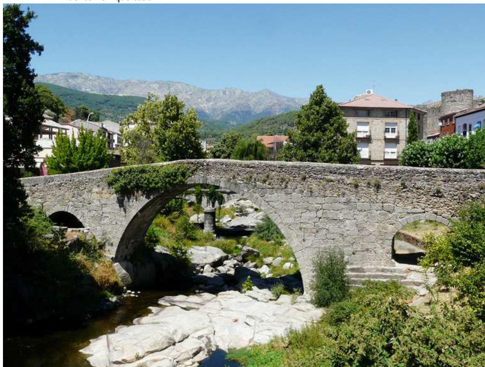
Puente de Aquelcabo
